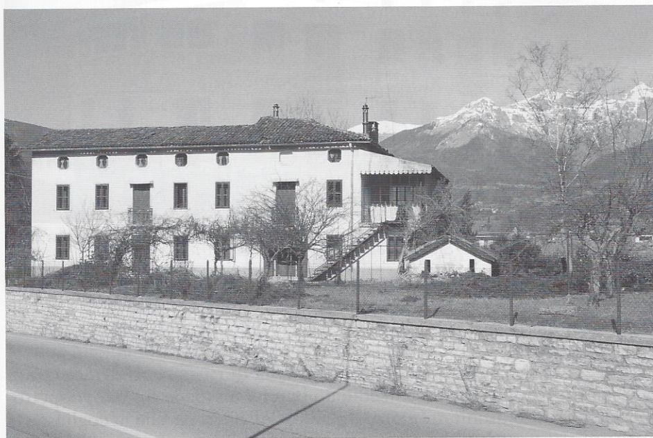
Figura 57 – Stato di fatto prima dell'intervento di ristrutturazione
