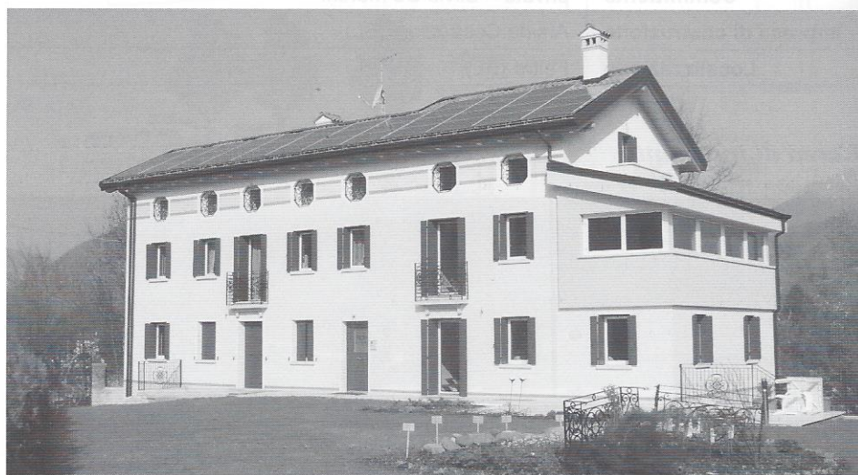
Figura 58 – Stato di fatto al termine della ristrutturazione
